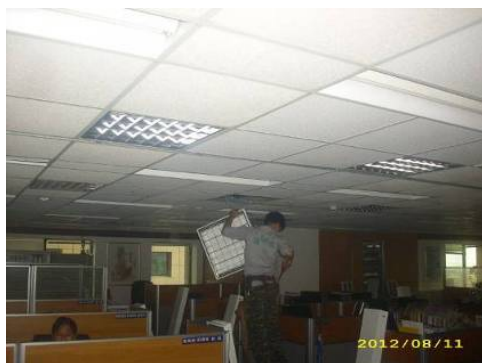
圖 3.4-6 汰換舊型燈具施工中
