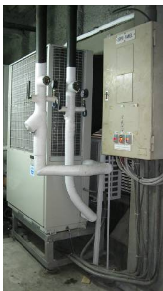
圖 3.4-4 汰換後之氣冷式冰水主機 圖 3.4-5 架設電表進行空調系統電力監控
