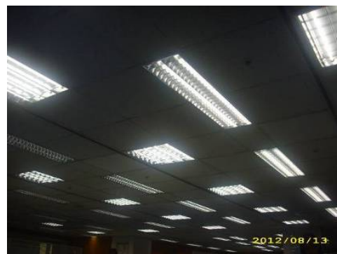
圖 3.4-7 汰換後之 T5 型燈管
