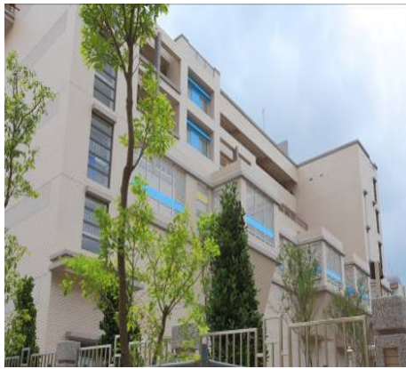
▲台電投中 D/S 與服務所共構土建設計/施工統包興建工程
